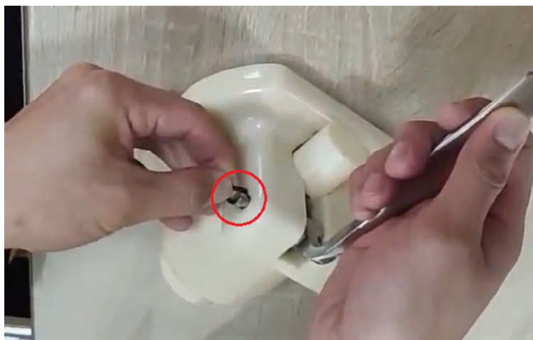
1. Odstraňte O-kroužek vřetene
