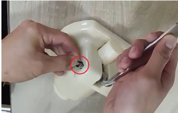
1. Entfernen Sie den O-Ring des Schafts
