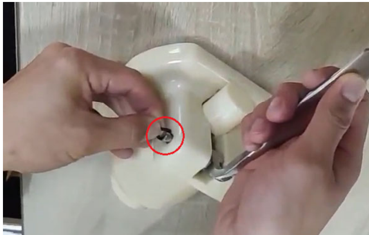
1. Verwijder de O-ring van de steel
