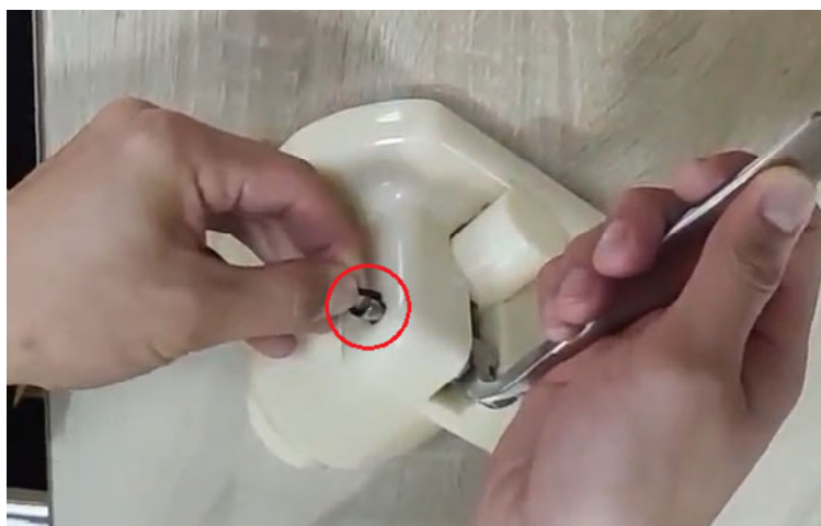
1. Отстранете O-пръстена на стеблото
