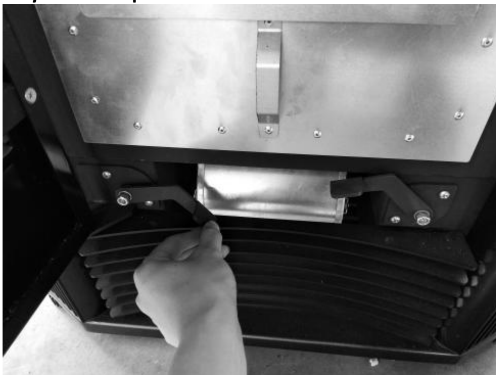
Čištění výměníku tepla
