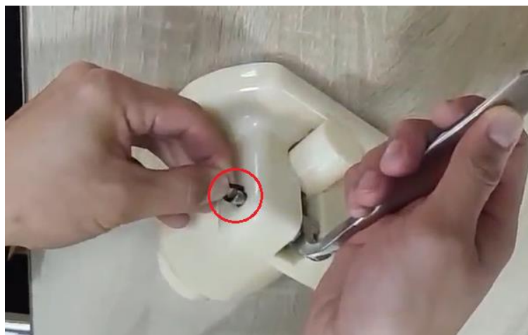
1. Fjern O-ring på spindlen
