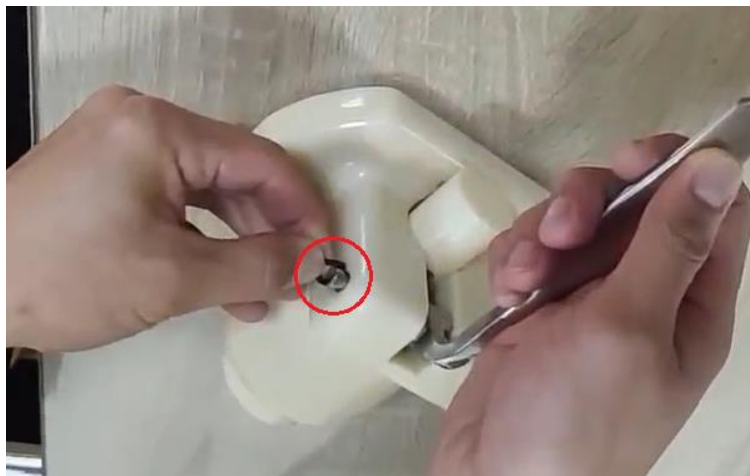
1. Zdejmij pierścień uszczelniający trzpienia
