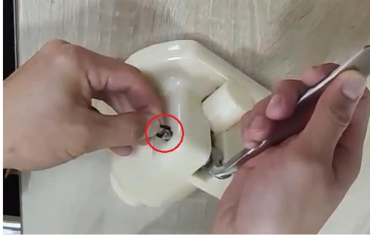
1. Retira la junta tórica del vástago
