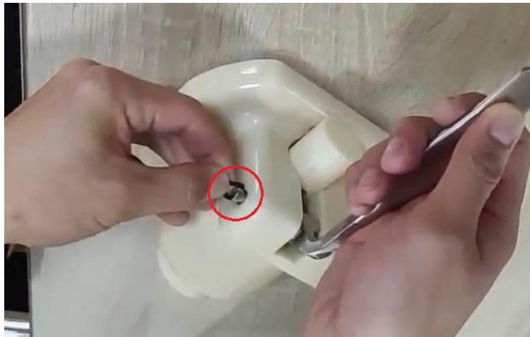
1. Αφαιρέστε τον δακτύλιο O του στελέχους
